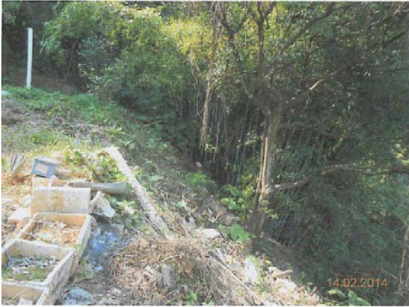
圖 16：事涉斜坡維修前
