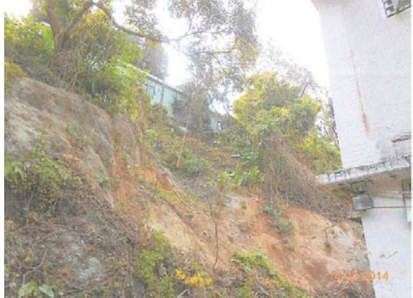
圖 17：事涉斜坡維修前
