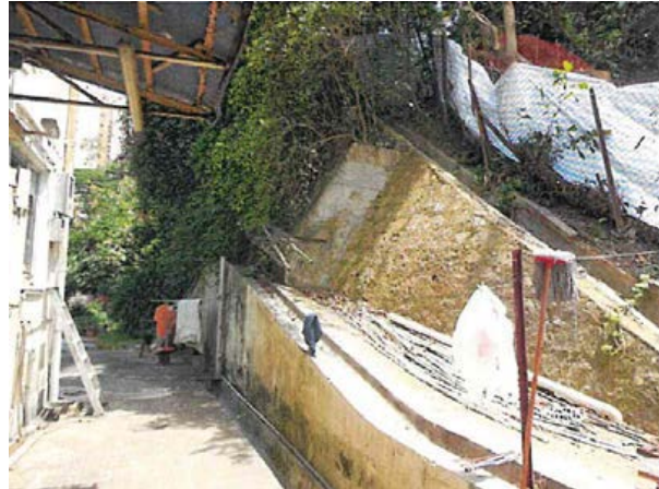
圖 8：事涉斜坡維修前
