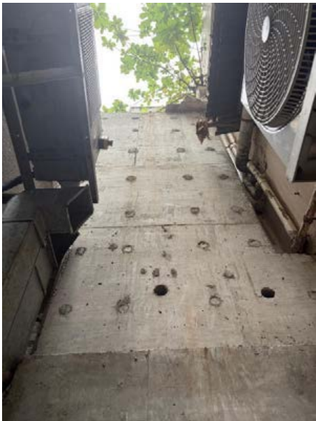
圖 3：事涉斜坡維修大致完成
