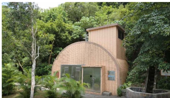
圖 30：「寶珊排水隧道—山泥傾瀉科技展學館」 （取自土拓署網站）
