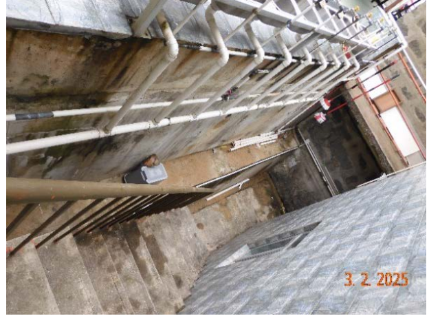
圖 6：事涉斜坡維修後
