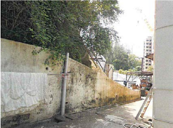
圖 7：事涉斜坡維修前
