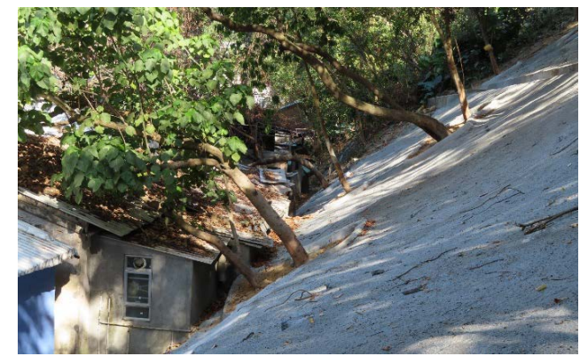
圖 23：事涉斜坡維修後
