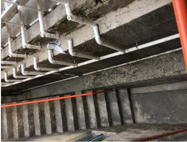
圖 5：事涉斜坡維修前
