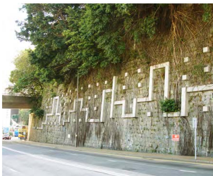
圖 7：裝設了泥釘的斜坡 (取自土拓署網站)
