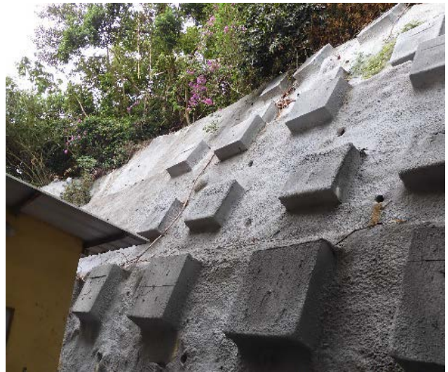
圖 15：事涉斜坡維修後
