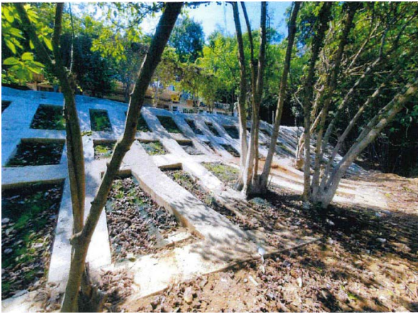
圖 18：事涉斜坡維修後
