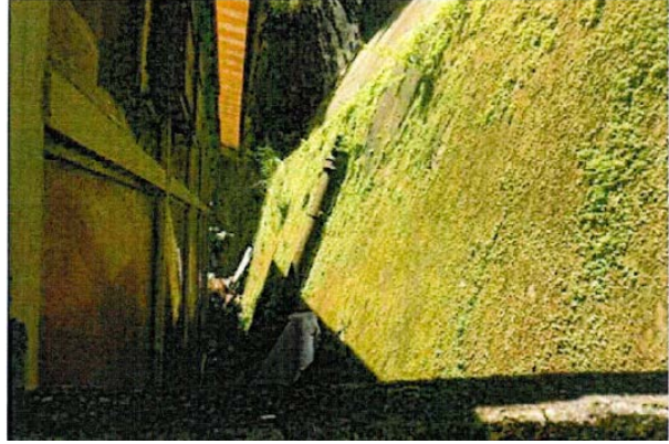
圖 13：事涉斜坡維修前
