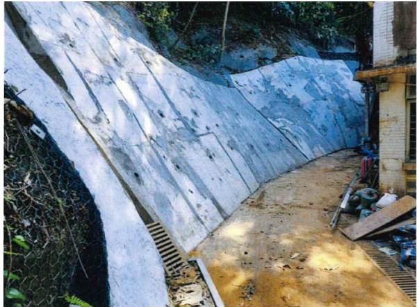
圖 19：事涉斜坡維修後
