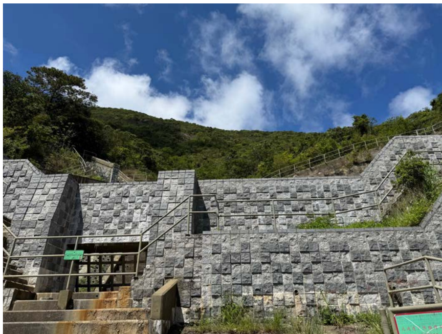
图 2：泥石坝 (公署人员拍摄)
