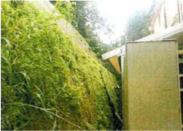
图 12：事涉斜坡维修前
