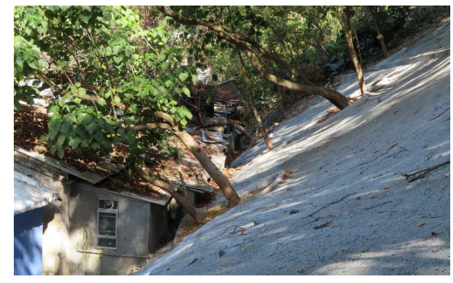
图 23：事涉斜坡维修后
