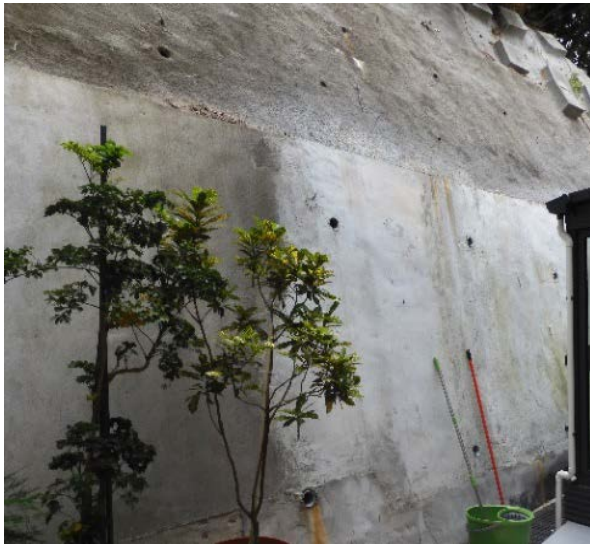
图 14：事涉斜坡维修后
