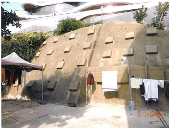
图 9：事涉斜坡维修后
