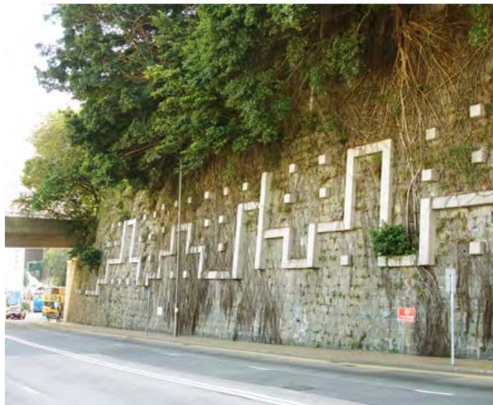
图 7：装设了泥钉的斜坡 （取自土拓署网站）
