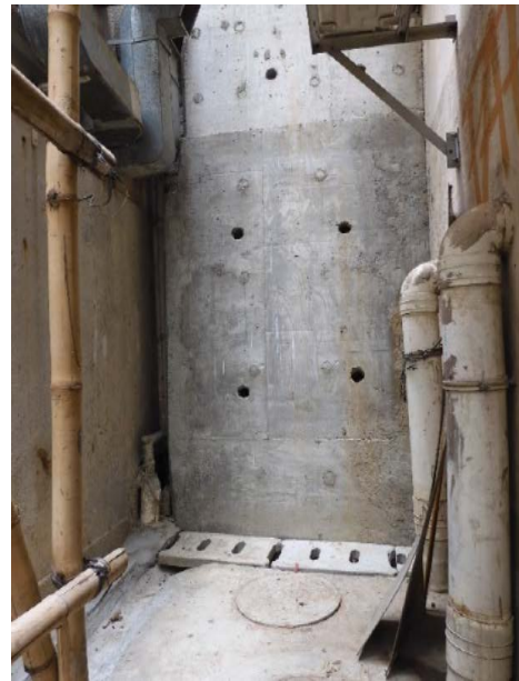
图 4：事涉斜坡维修大致完成
