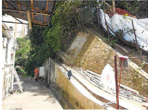
图 8：事涉斜坡维修前
