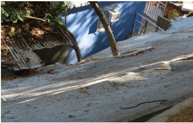
图 22：事涉斜坡维修后
