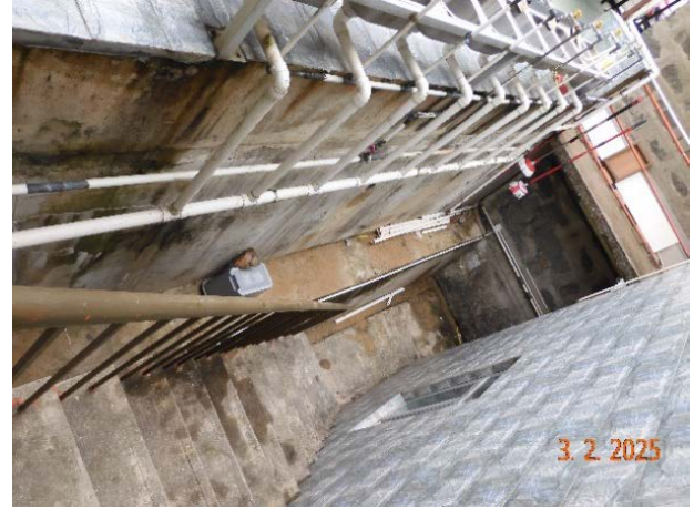
图 6：事涉斜坡维修后
