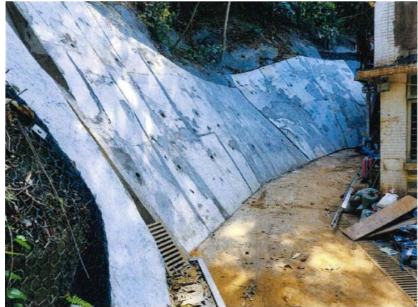
图 19：事涉斜坡维修后
