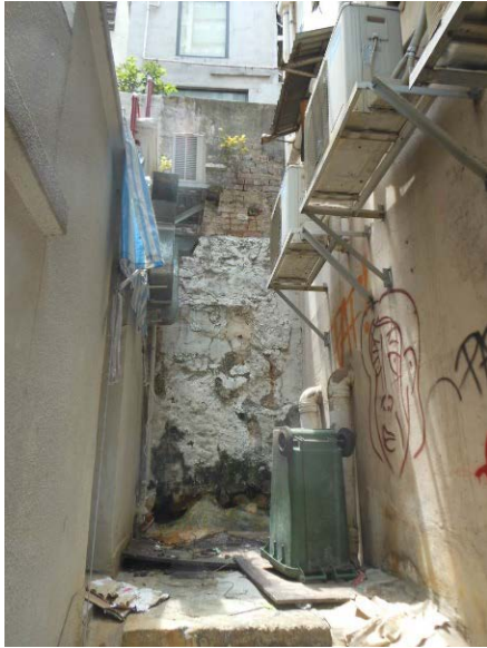
图 1：事涉斜坡维修前
