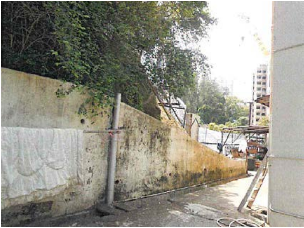
图 7：事涉斜坡维修前
