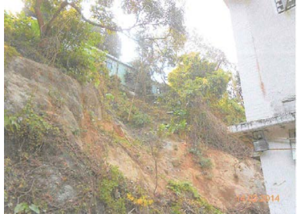
图 17：事涉斜坡维修前
