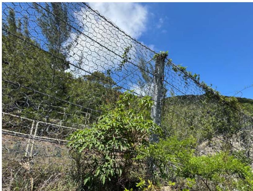
图 2：位于浅水湾道上方的柔性防护网 （公署摄于 2025 年 5 月的实地视察）
