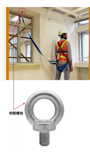
圖 8：有眼螺栓及工人使用有眼螺栓時的情況 ( 取自勞工處的《懸空式竹棚架構造及工作安全指南》 )
