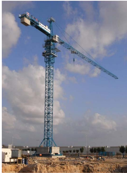
圖 12：塔式起重機（俗稱「天秤」） （取自勞工處網站）
