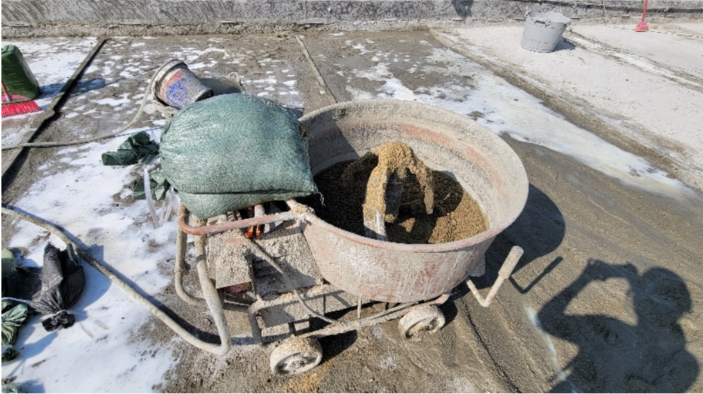
图 3：电动搅拌机开泥时未有使用安全罩 (由公署人员于 2024 年 1 月拍摄)
