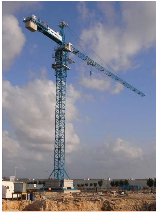
图 12：塔式起重机（俗称「天秤」） （取自劳工处网站）
