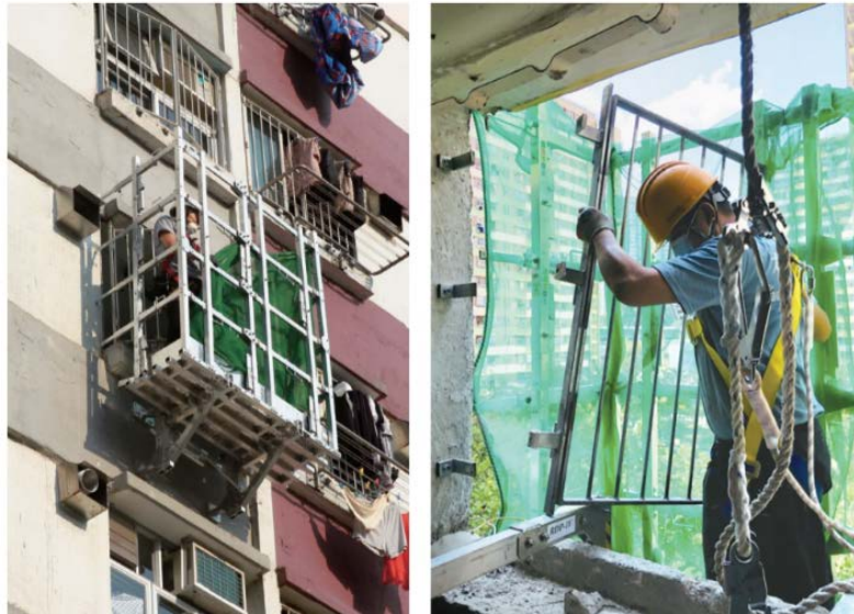
图 25：快速安装工作平台 (取自职安局网站)
