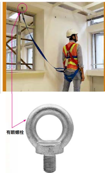
图 8：有眼螺栓及工人使用有眼螺栓时的情况 (取自劳工处的《悬空式竹棚架构造及工作安全指南》)
