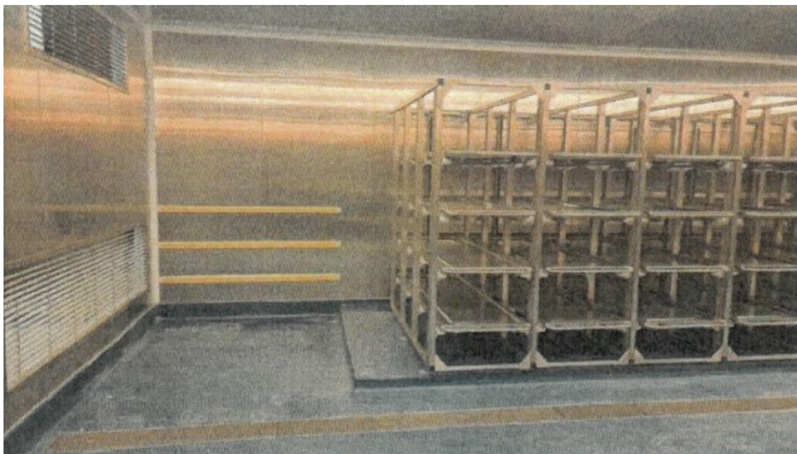
图 4：新富山公众殓房冷藏室内的固定遗体贮存装置
